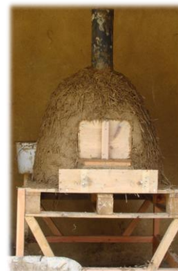
Photos des temps de participation à la construction d'un four à pain aux Plomarc'h en septembre, pour préparer le projet de construction de celui de Kermarron
